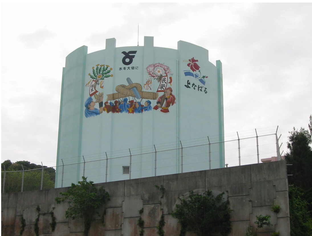
与那原第二配水池（江口区）
