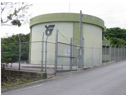
板良敷配水池（板良敷区）
