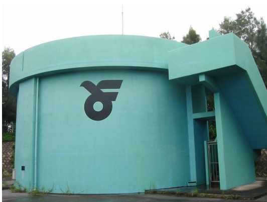
大見武配水池（大見武区）
