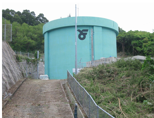
与那原第一配水池（大見武区）
