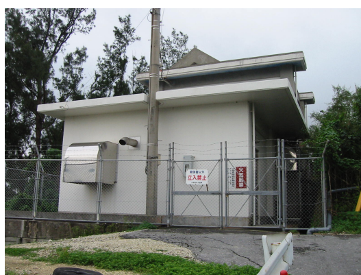
板良敷ポンプ室（板良敷区）
