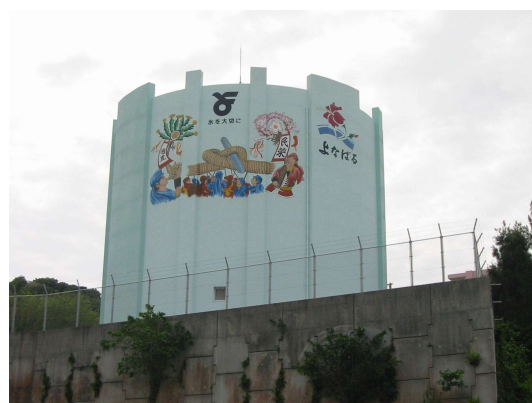
与那原第二配水池（江口区）
