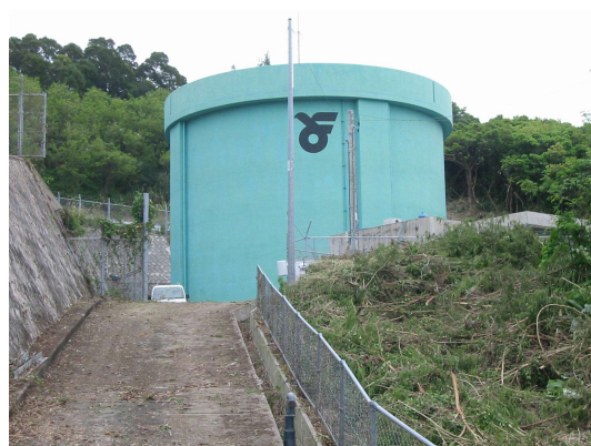
与那原第一配水池（大見武区）
