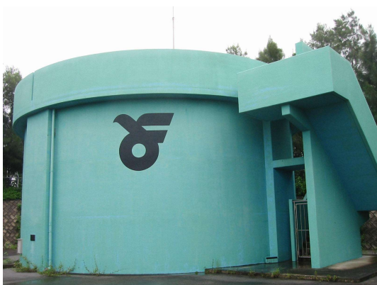
大見武配水池（大見武区）
