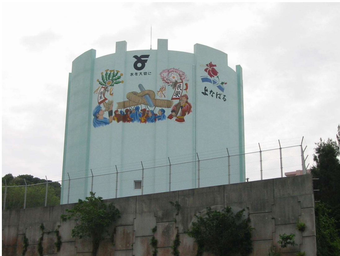
与那原第二配水池（江口区）
