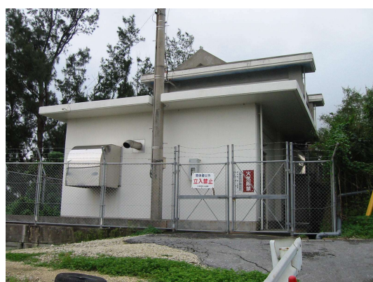
板良敷ポンプ室（板良敷区）
