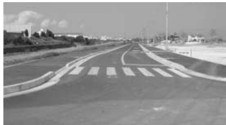
補助幹線2号線道路改築事業（東浜地内）
