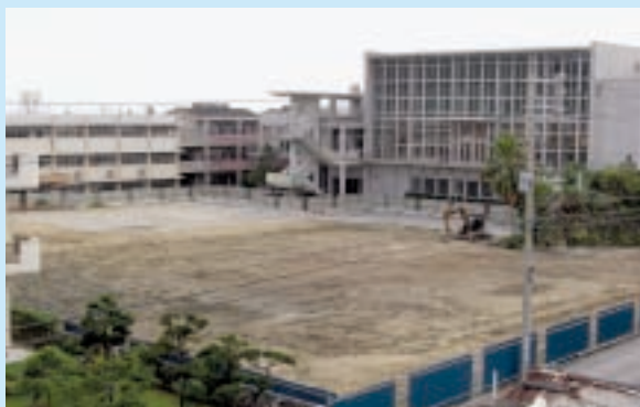
① 仮設(遣り方)工事終わりました。
