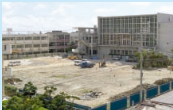
② 屋外排水設備工事終わりました。
