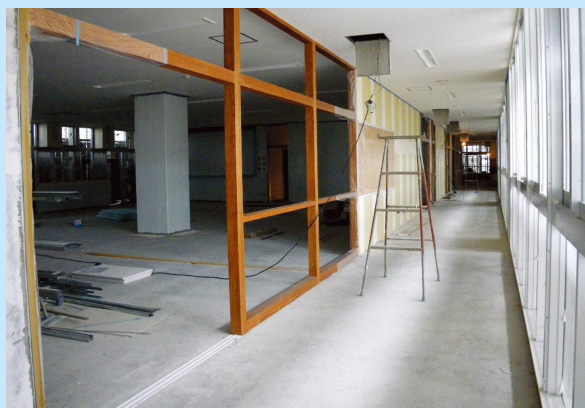
2階の普通教室の工事状況
