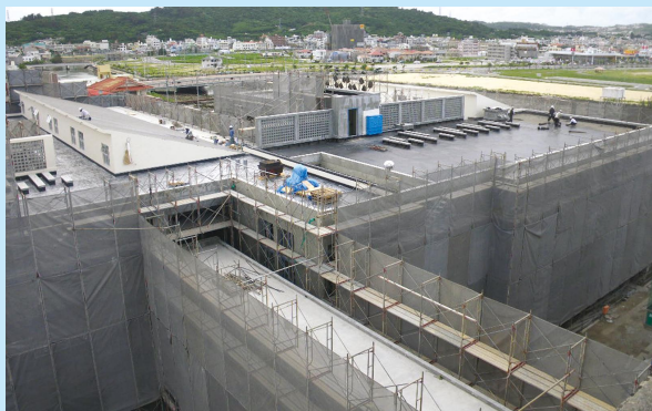
屋根の防水工事
