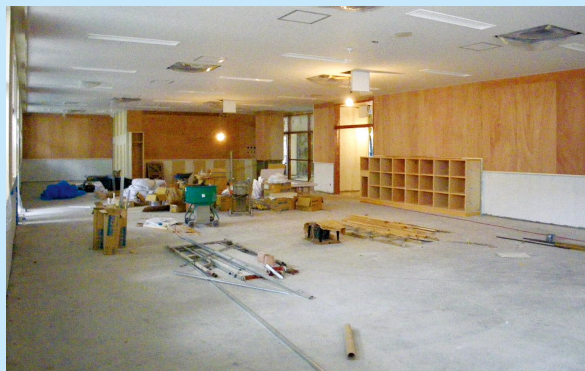
図書室の天井、床工事
