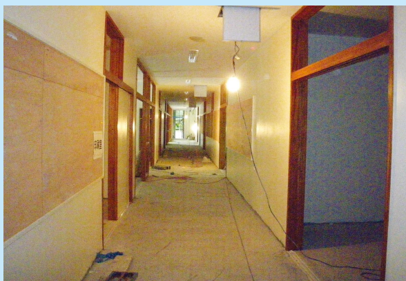
1階廊下の工事状況
