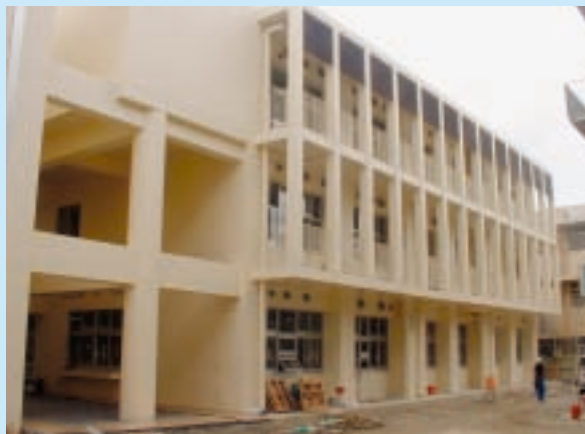
特別教室棟の状況
