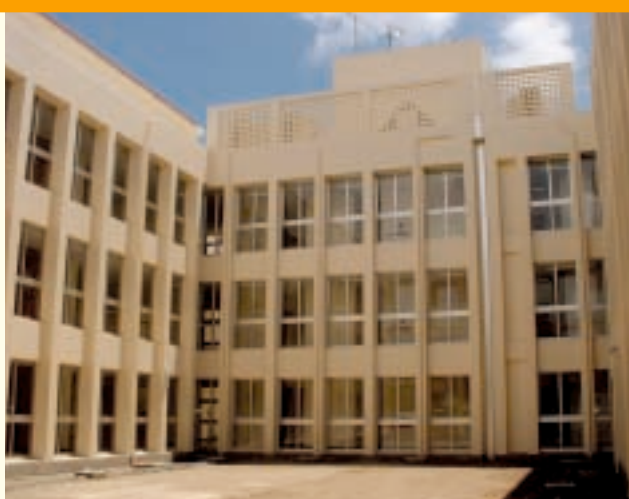
B棟普通教室棟・特別教室棟
