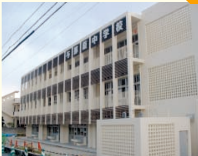
A棟普通教室棟
