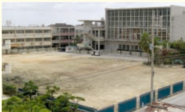
着工前（平成20年9月）
