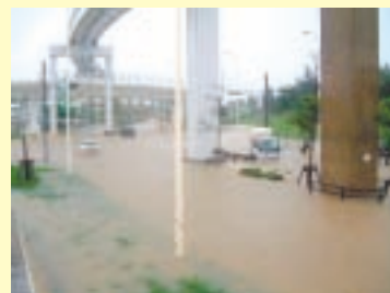
浸水害の様子
