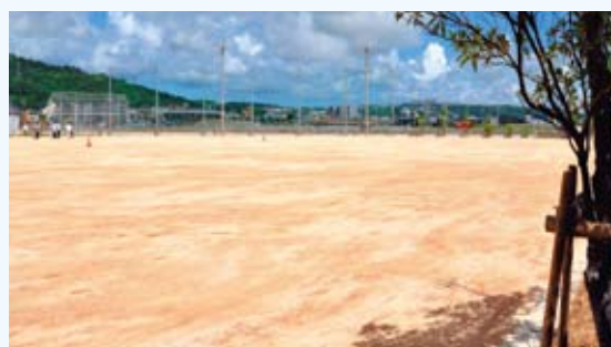
与那原中学校建設事業（運動場整備）
