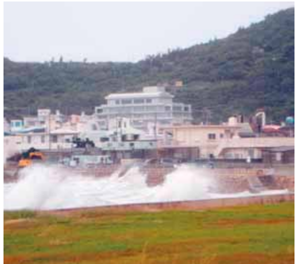
10月10日朝の板良敷海岸。波が防波堤を乗り越え車道を襲う
