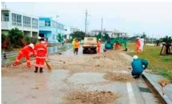
10月12日、砂泥で覆われた道を地元事業者と町職員が復旧作業
