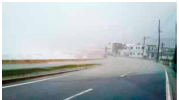
冠水した板良敷沿岸線
