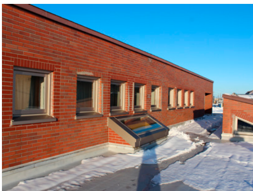
● 霧多布保育所改修工事
