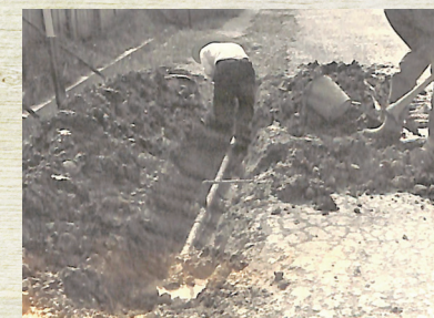
水道管敷設工事の様子1968年頃
