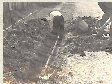
水道管敷設工事の様子1968年頃
