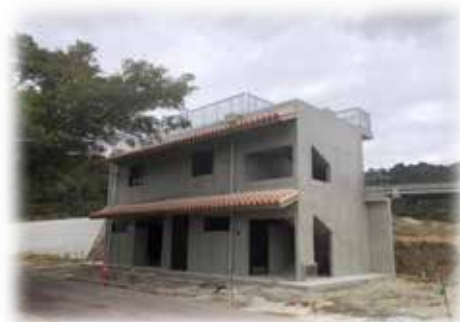
与原公園新設トイレ
