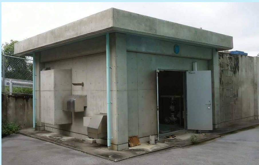
大見武ポンプ場 2001（平成13）年度竣工
