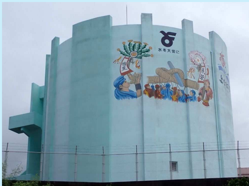
与那原第二配水池 1,620m 3 2001（平成13）年度竣工
