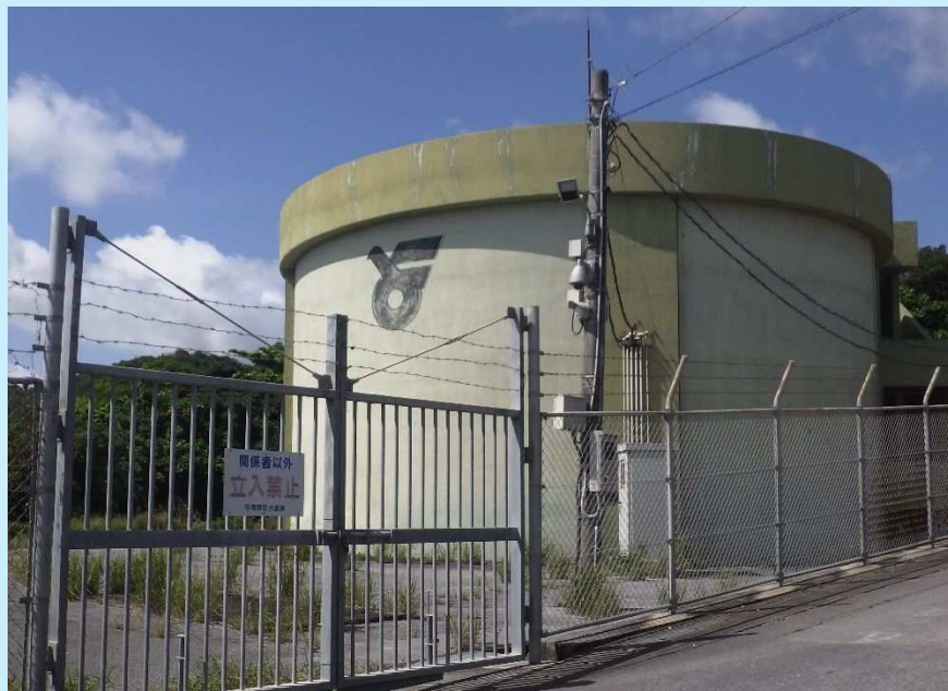
板良敷配水池 1,000m 3 1992（平成4）年度竣工
