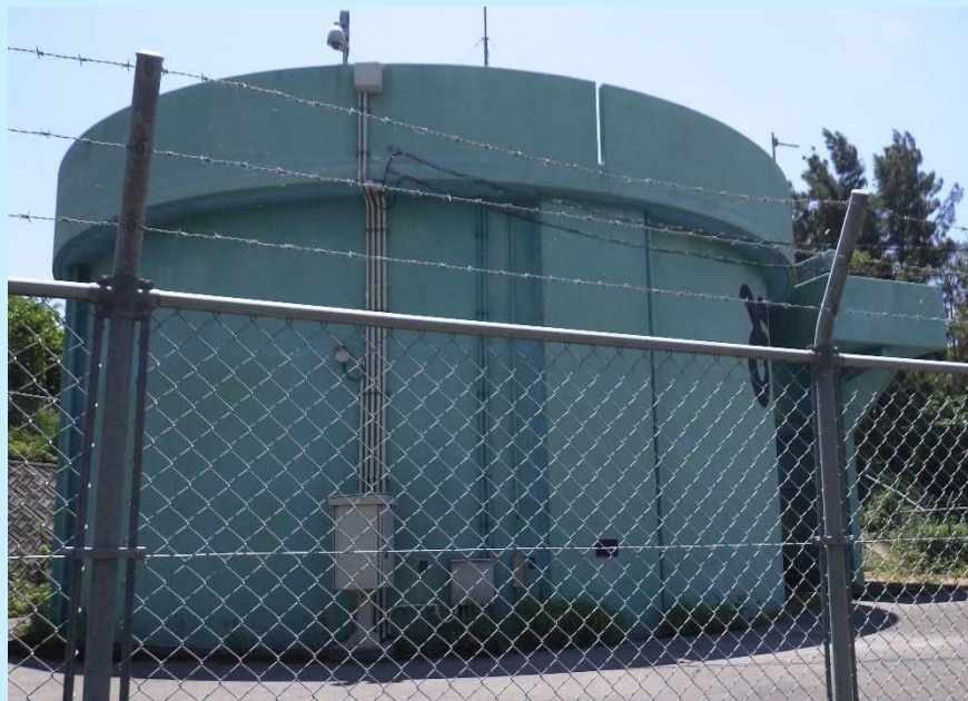
大見武配水池 510m 3 2001（平成13）年度竣工
