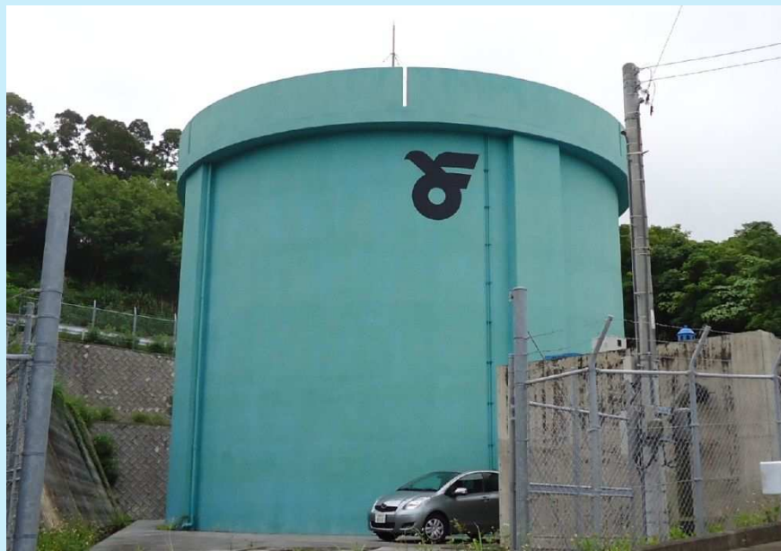
与那原第一配水池 1,300m 3 2001（平成13）年度竣工
