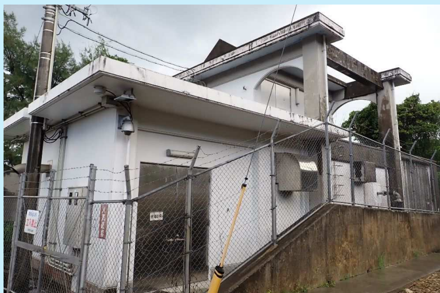
板良敷ポンプ場 1992（平成4）年度竣工
