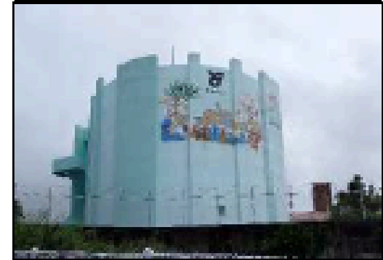
与那原第二配水池 容量：1,620 m 3 2002 (H14) 年度竣工
