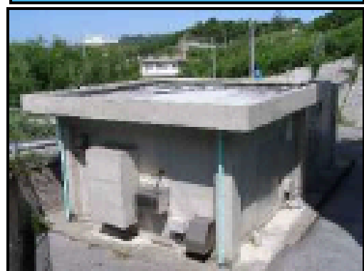
大見武ポンプ場 容量：510 m 3 2000 (H12) 年度竣工
