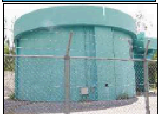
大見武配水池 容量：510 m 3 2001 (H13) 年度竣工
