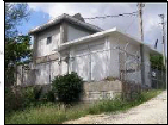
板良敷ポンプ場 1992 (H04) 年度竣工
