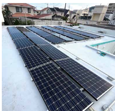
パネル枚数 36枚 容量 8.7kW
