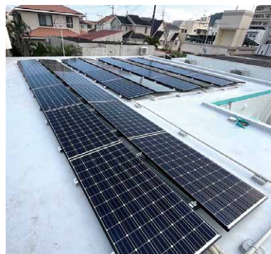
パネル枚数 36 枚 容量 8.7kW
