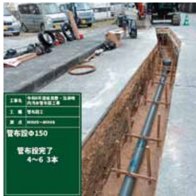
町内の汚水管敷設工事
