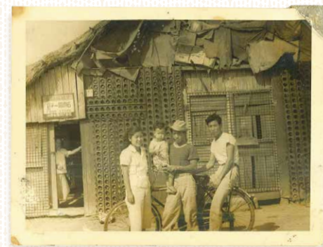
写真② 配給所が廃止された後に与那原販売店となった。壁には、米軍が物資の集積所とした際に用いたミーファー鉄板が柱に代わって補強されている様子が確認できます。
