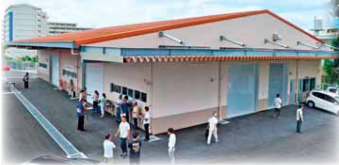
▲江口区に5月末完成した大綱曳倉庫
