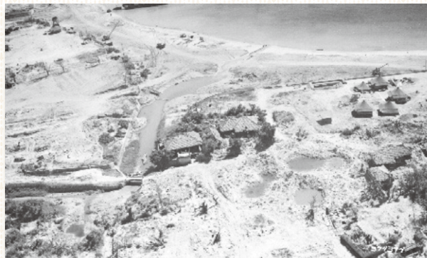
廃墟となった与那原(沖縄県公文書館所蔵) 左の川はサイラガーウ。左上は与那原国民学校敷地。
