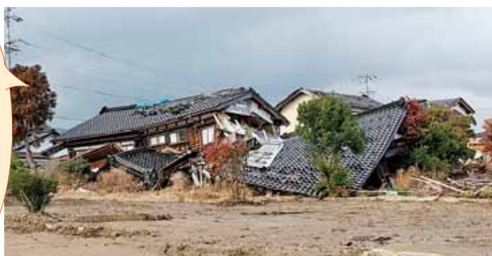
1年経過しても復興以前の復旧段階の地区もある
