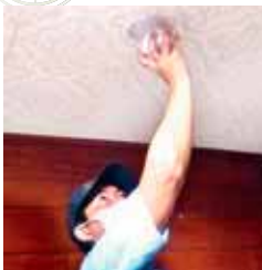
▲ 火災警報器の設置作業
