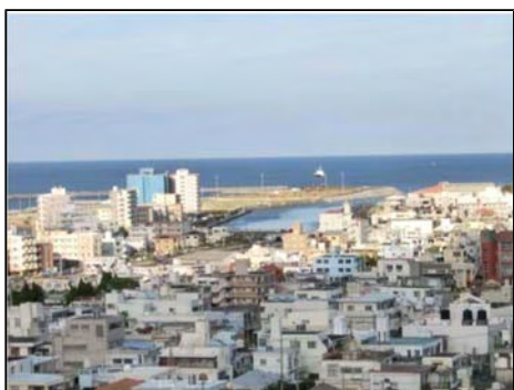
県営須利原団地からみる新市街地
