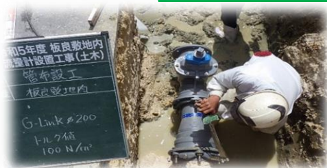
水道管布設工事の様子
