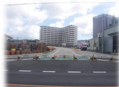
工事中の上与那原前の井（メニューカー）線
