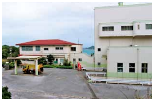
老朽化した「東部環境美化センター」
