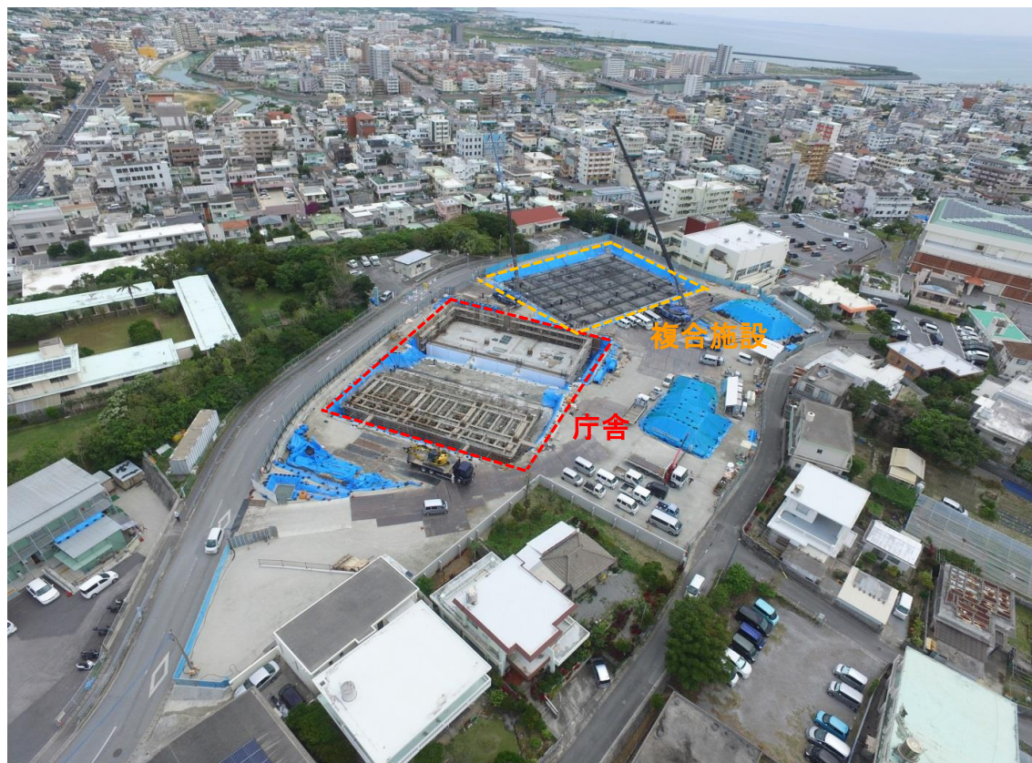
②全景写真【西側より】
