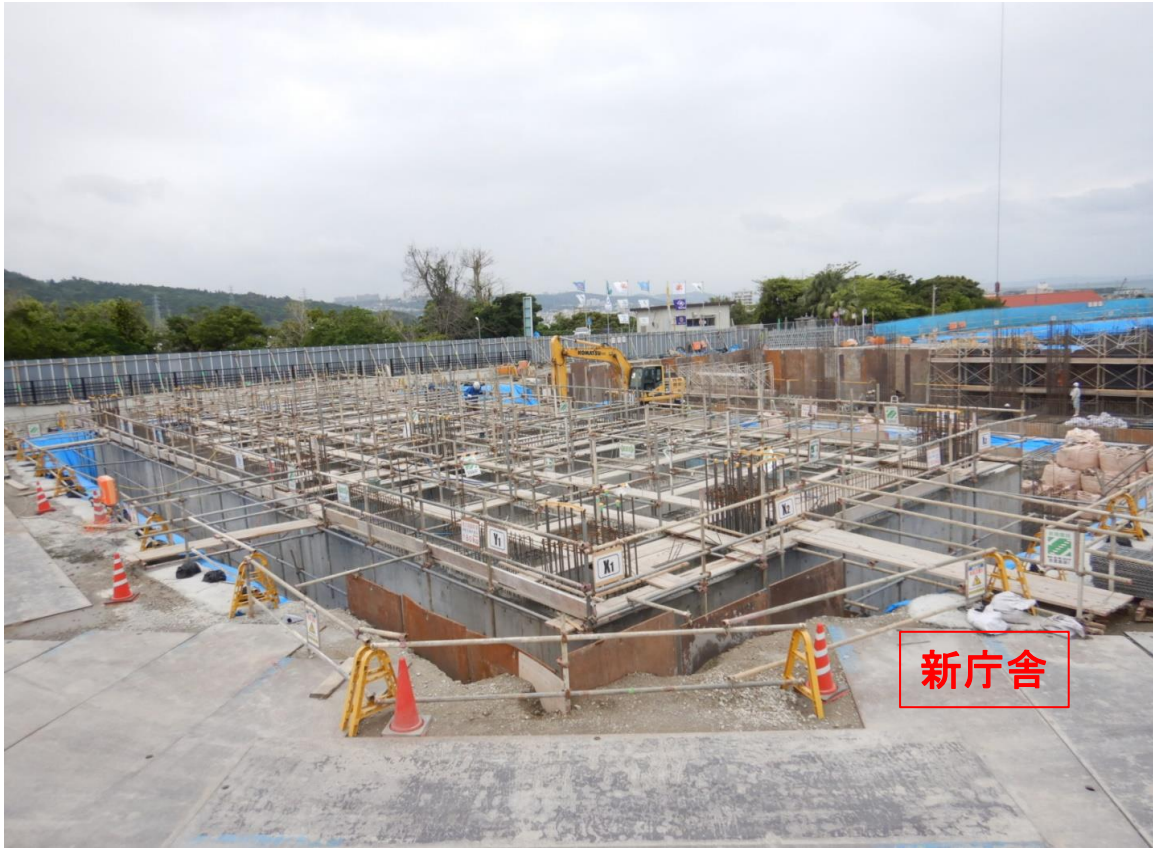
①新庁舎 地中梁型枠脱型後、養生中。
