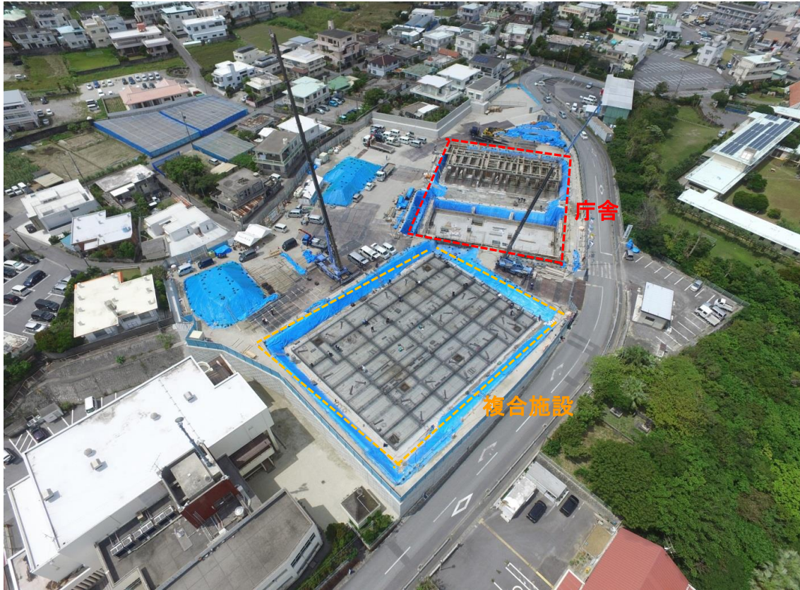
①全景写真【東側より】
