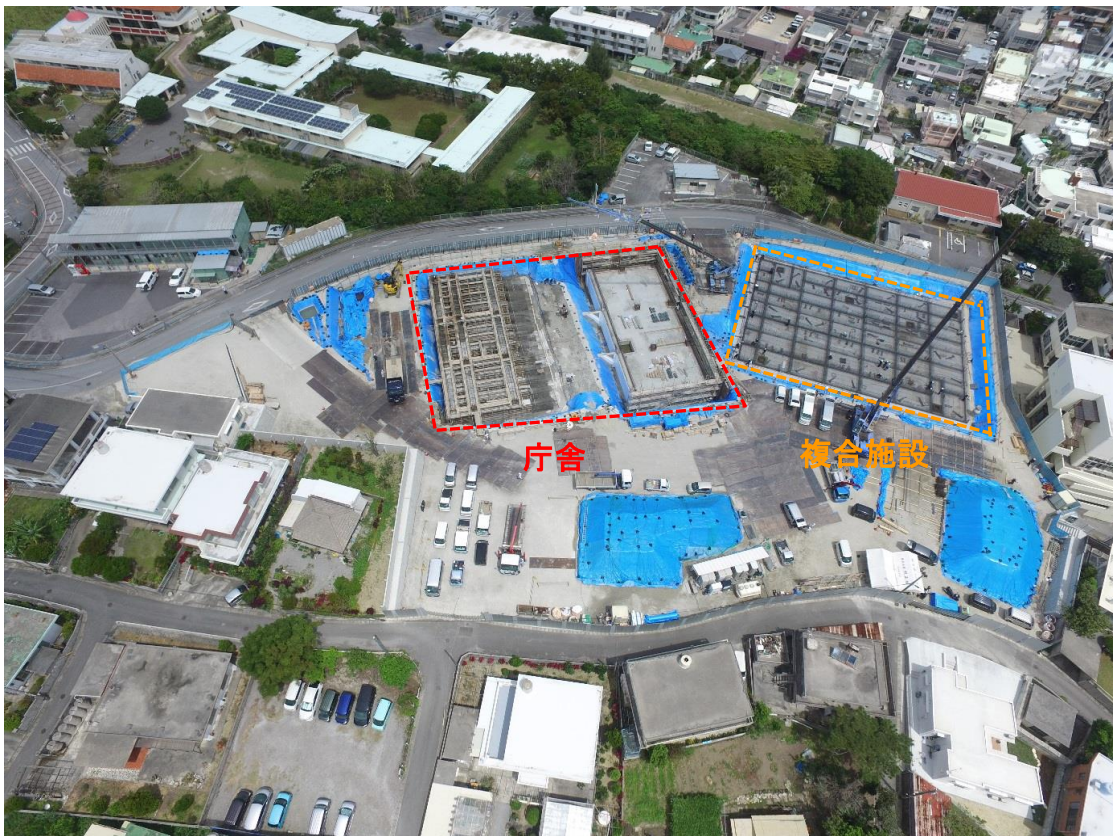
②全景写真【南側より】
