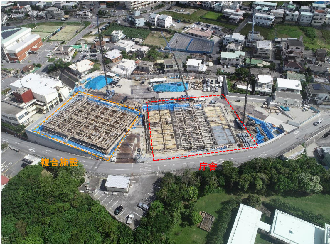
①全景写真【北側より】
