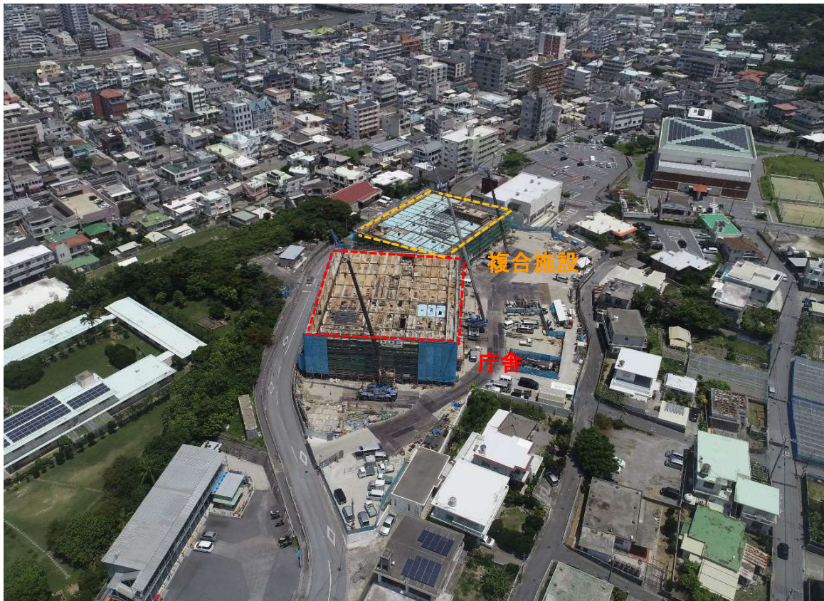
②全景写真【西側より】
