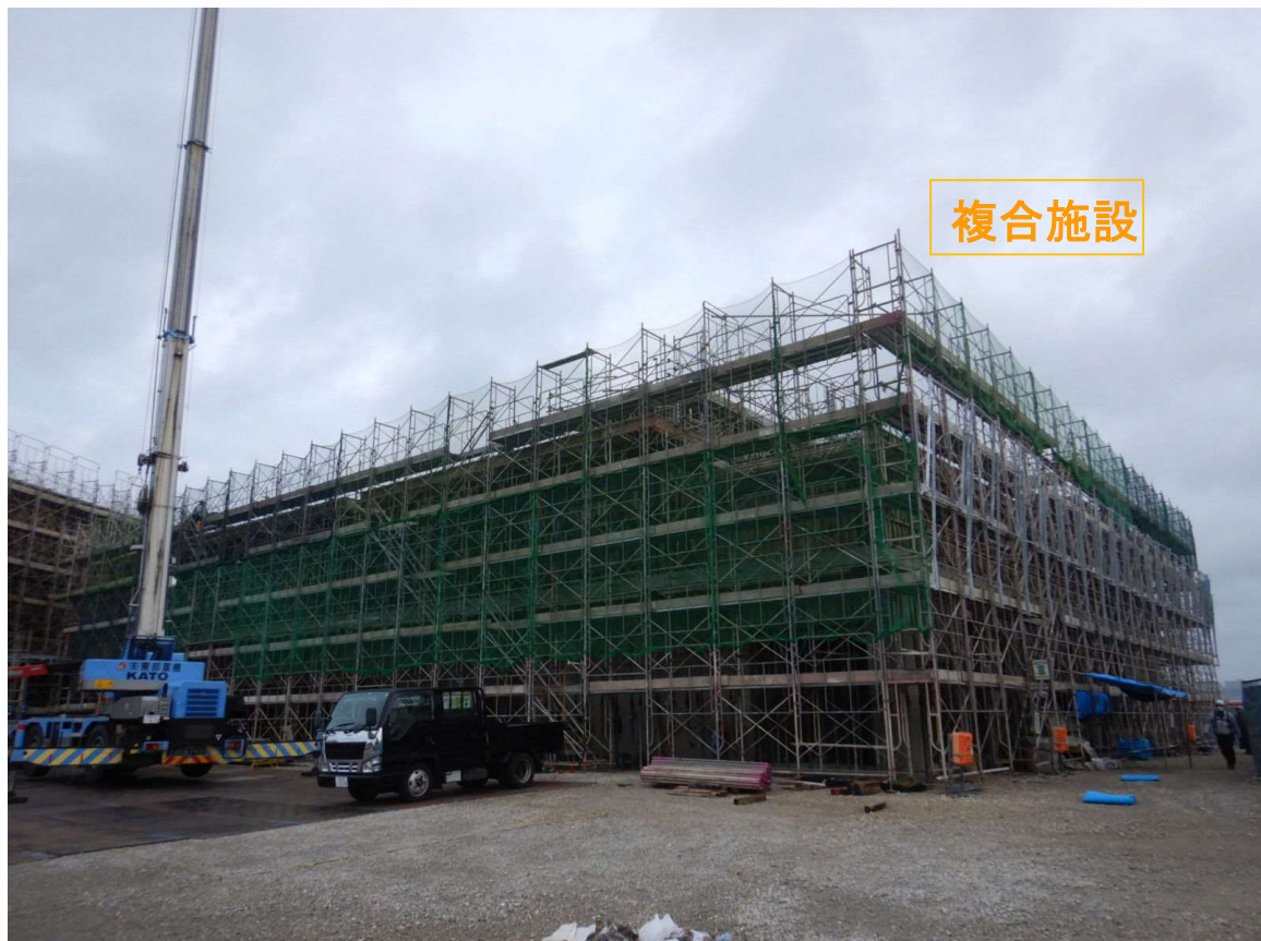
②複合施設 2階梁配筋状況。R階柱・断熱材打ち込み完了。
