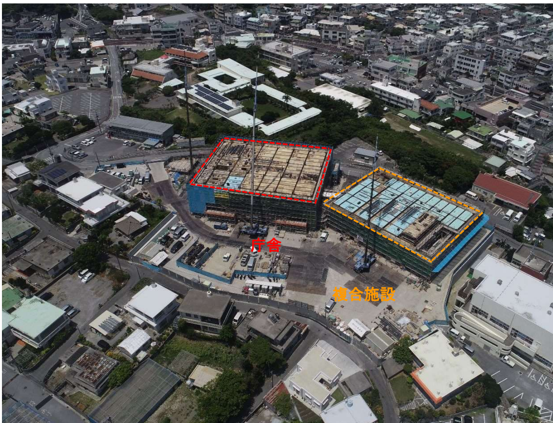
②全景写真【南側より】
