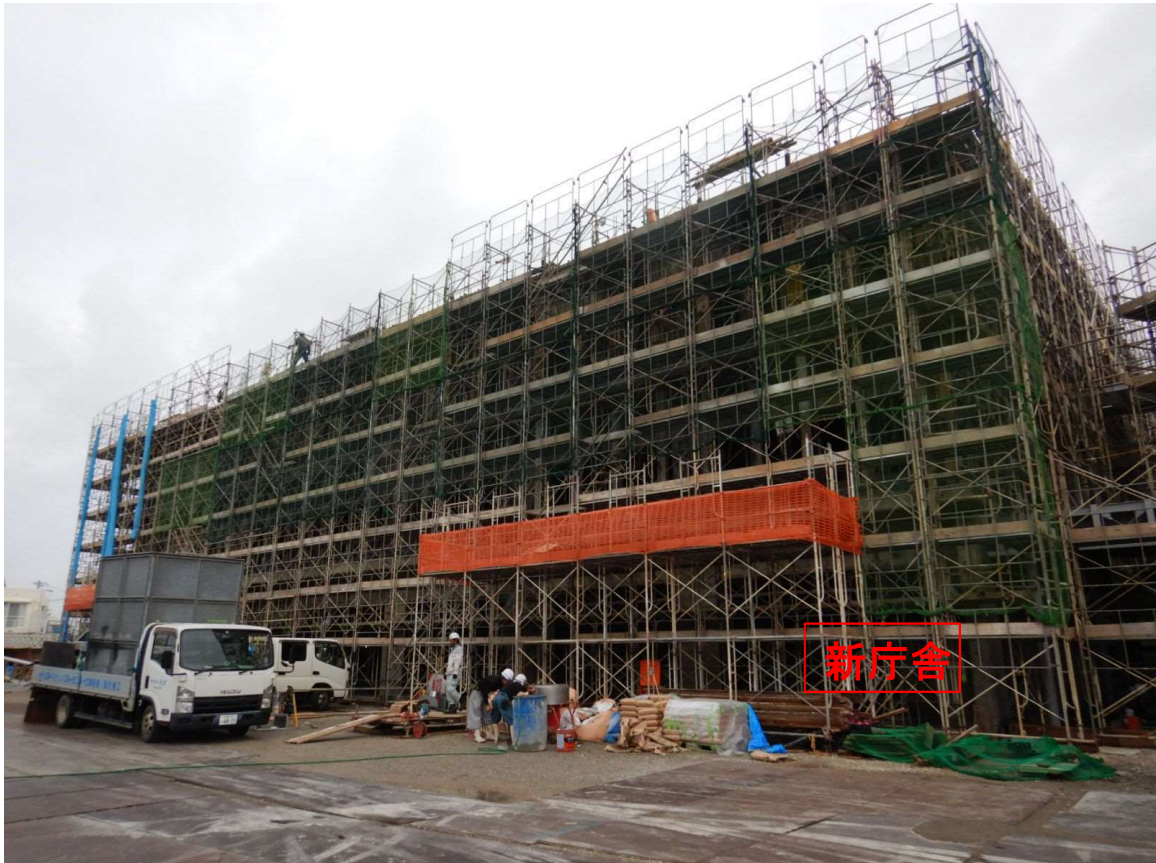
①新庁舎 3階梁配筋状況。4階床スラブ配筋状況。
