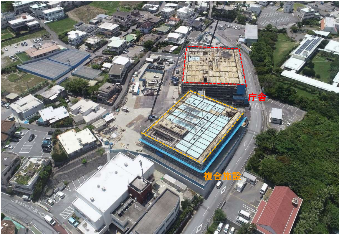
①全景写真【東側より】
