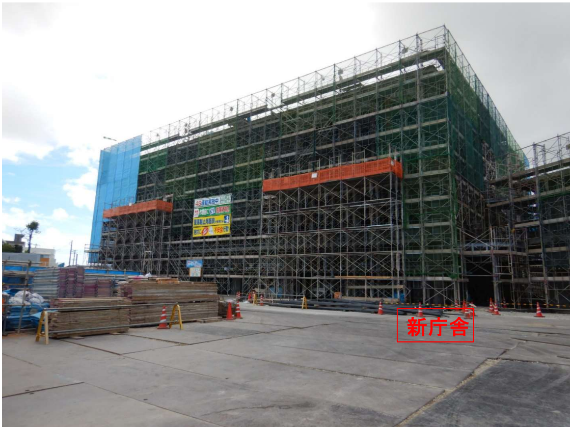
①新庁舎 R階梁・スラブ配筋。
