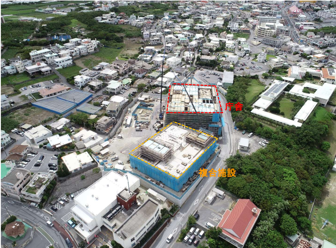
①全景写真【東側より】
