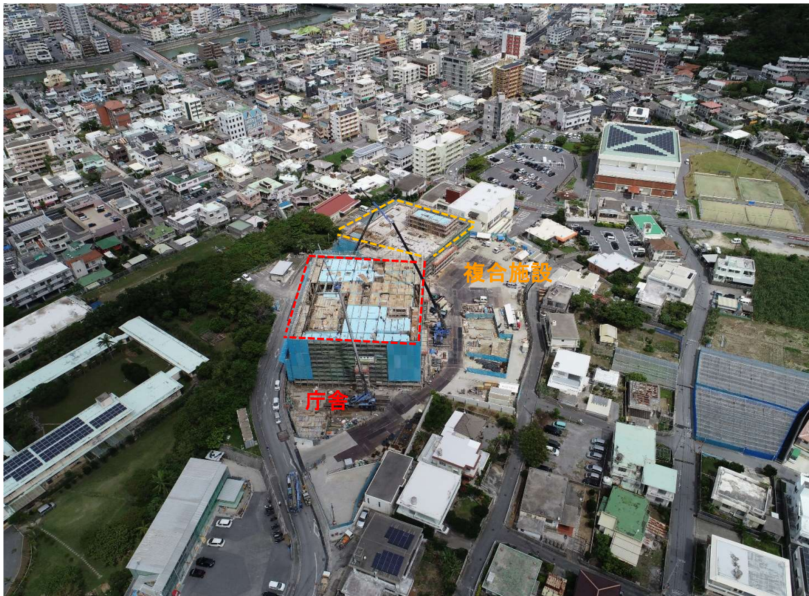
②全景写真【西側より】
