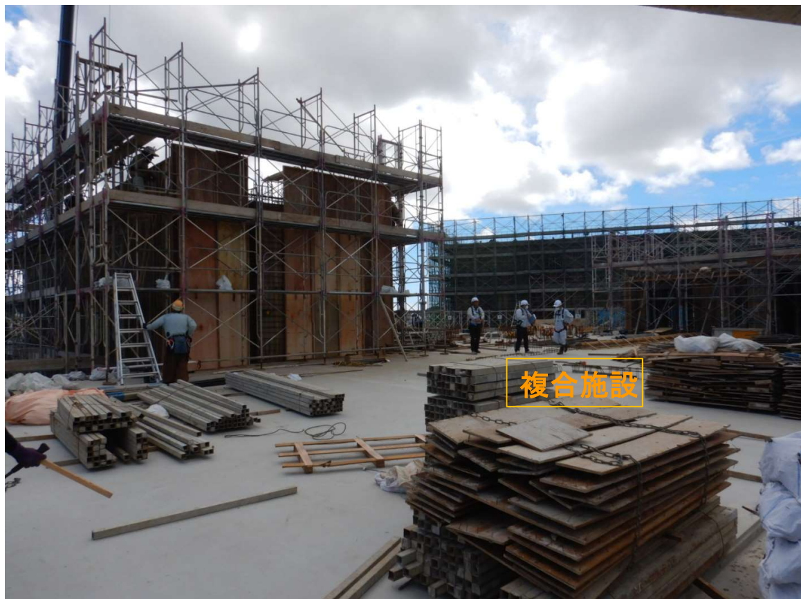
②複合施設 PH階梁・スラブ配筋。
