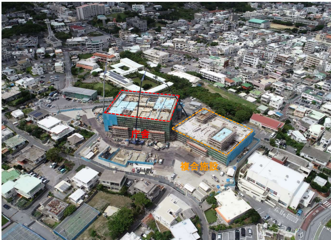
②全景写真【南側より】
