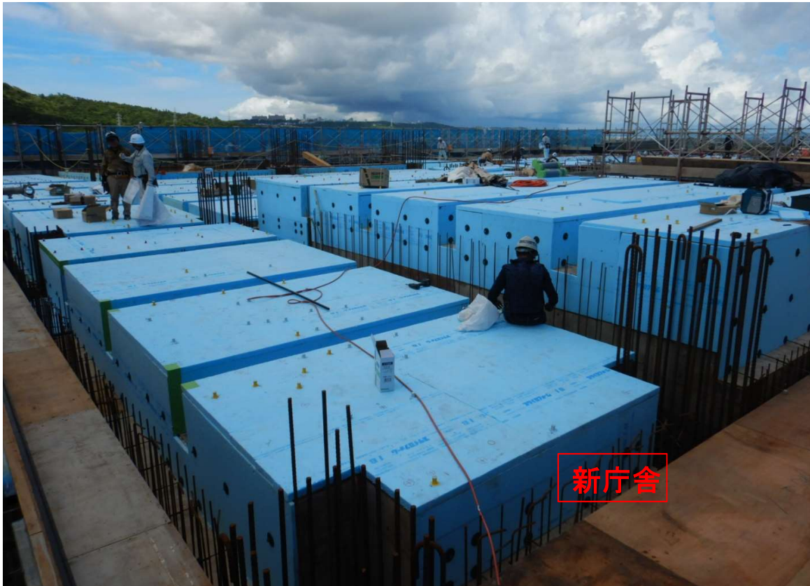
①新庁舎 R階梁・スラブ配筋。
