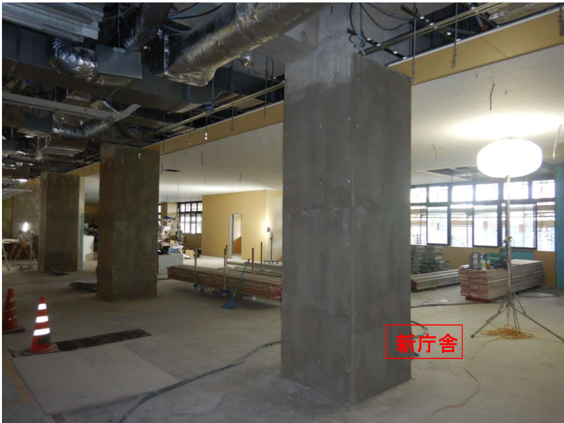
①新庁舎 1階-軽鉄壁・天井下地ボード貼り
