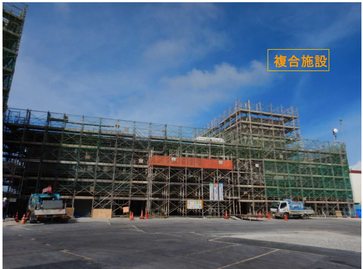
②複合施設 外部左官補修。
