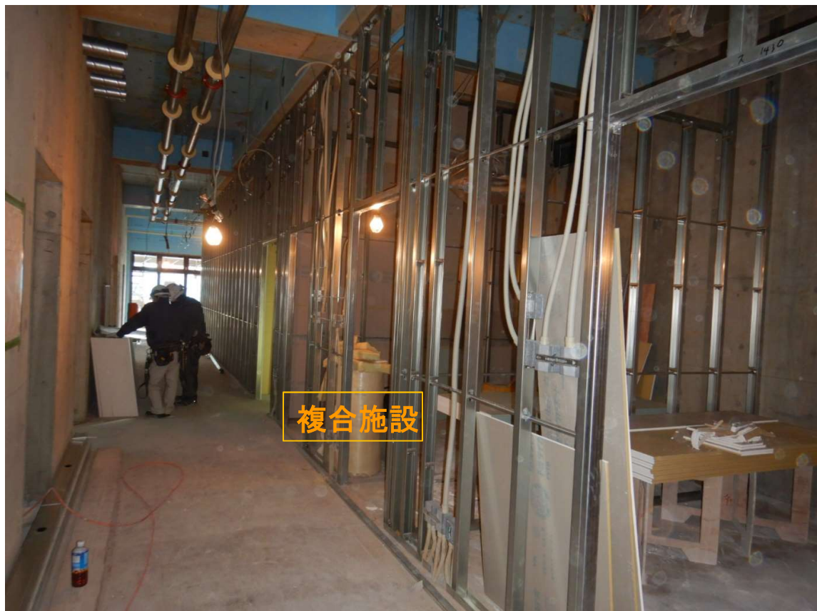
②複合施設 2階-軽鉄壁下地組み。
