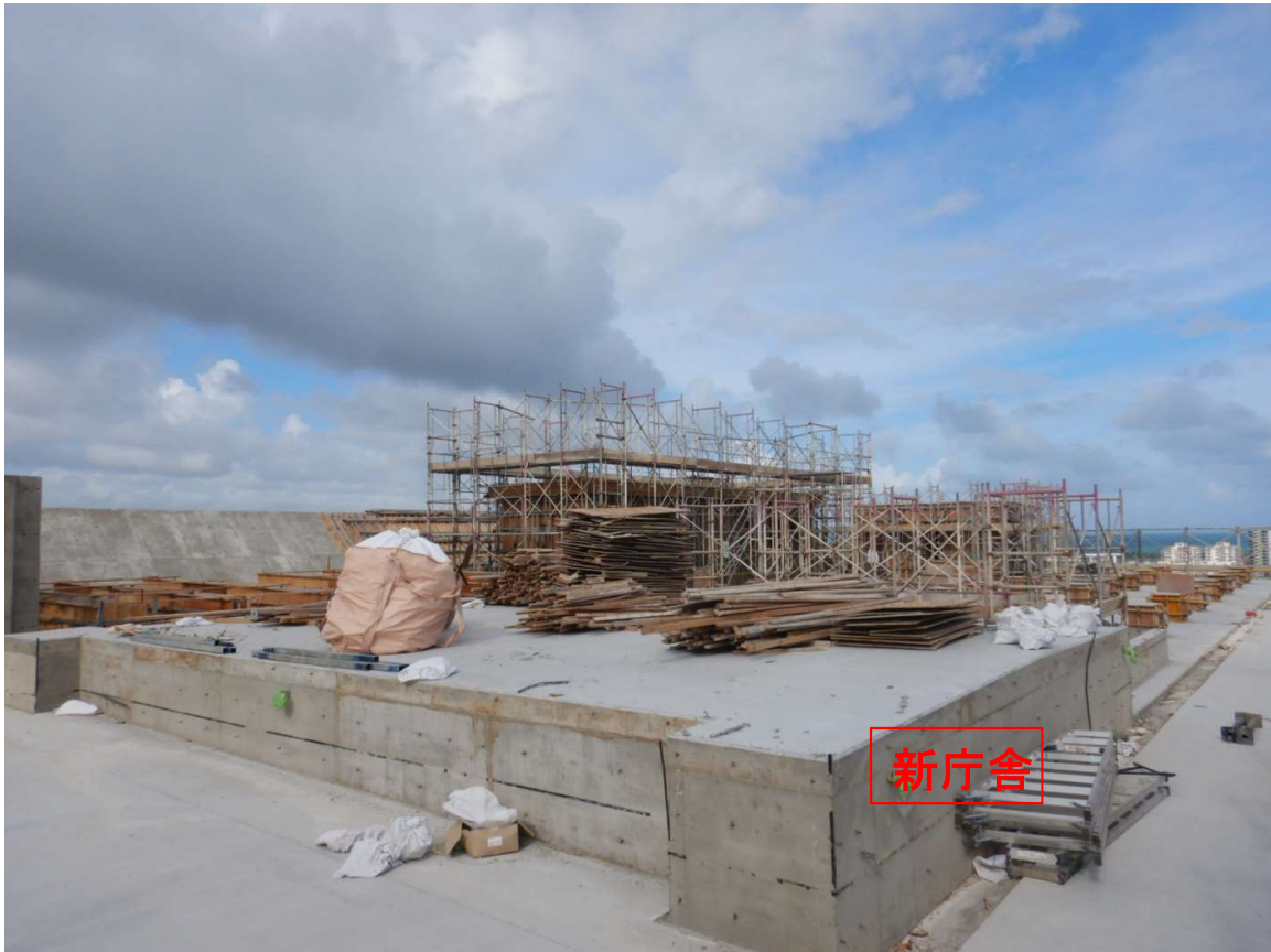
①新庁舎 外部左官補修。2F赤瓦マスブロック準備工。
