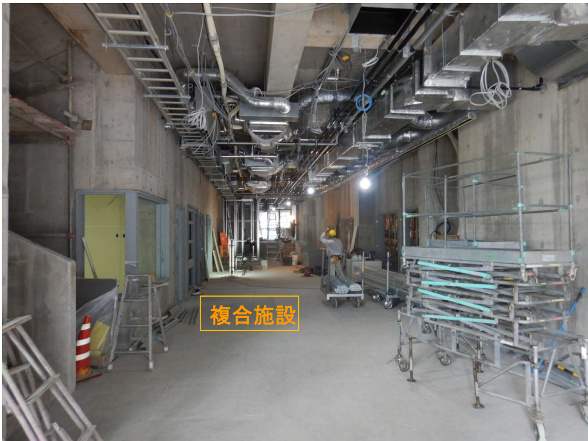
②複合施設 1階-軽鉄壁下地ボード貼り。
