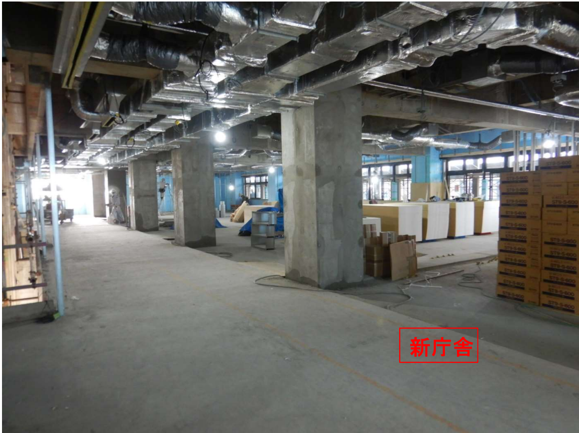
①新庁舎 2階-軽鉄壁下地ボード貼り
