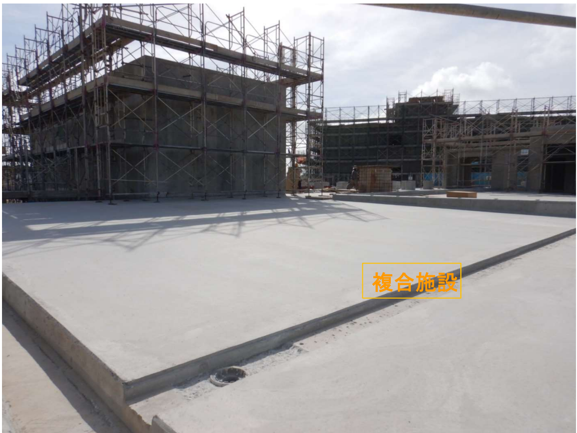
②複合施設 外部左官補修。
