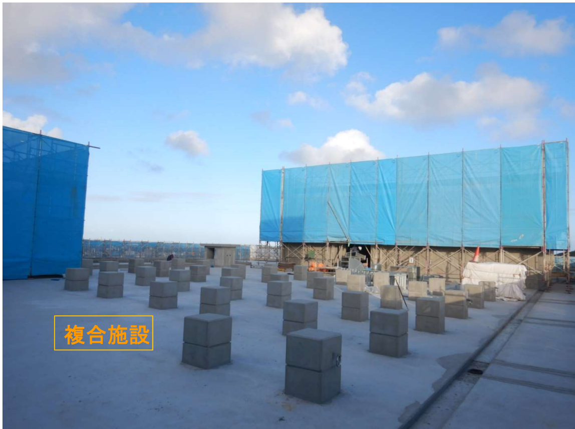
②複合施設 太陽光基礎-施工完了。
