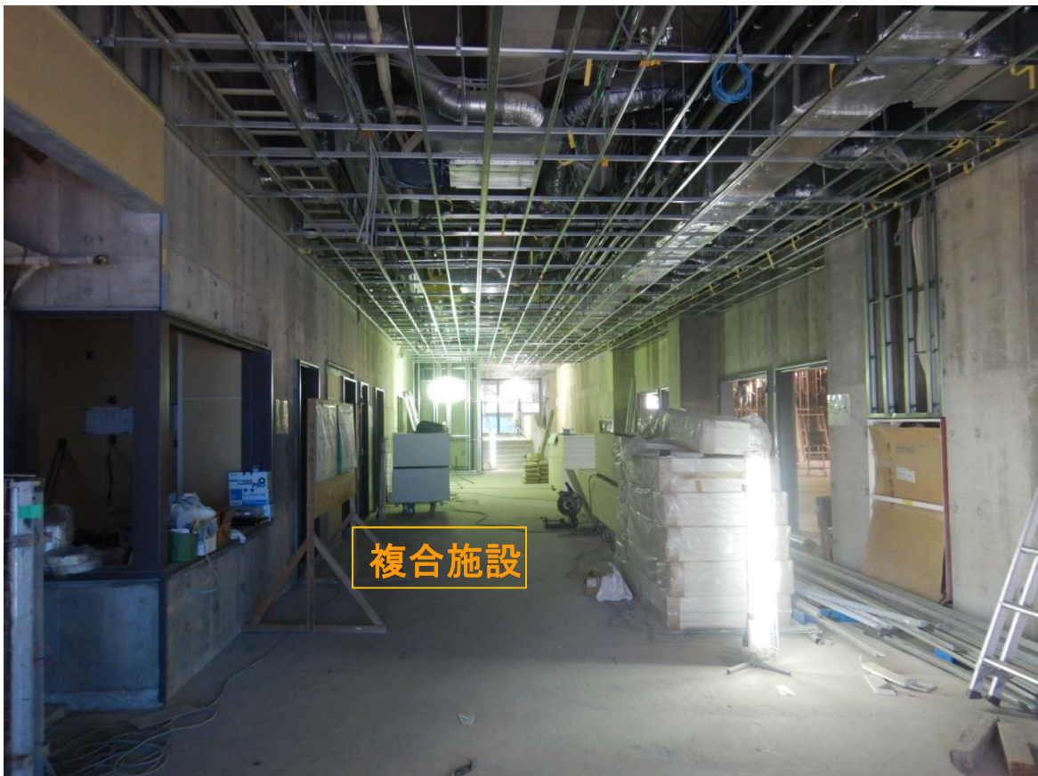
②複合施設 1階-天井軽鉄下地組み完了。
