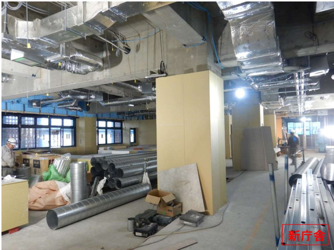
①新庁舎 3階-軽鉄壁下地ボード貼り
