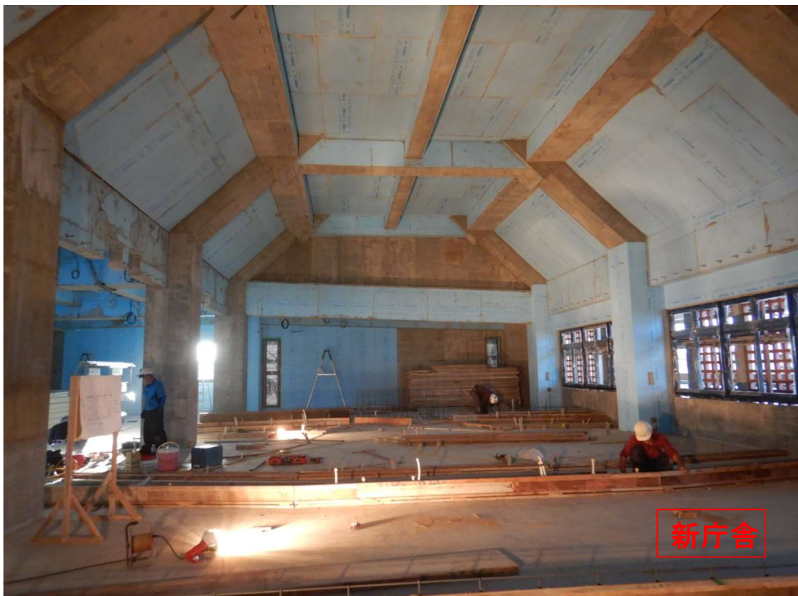
②新庁舎 4階(議場)型枠解体。内部立ち上がり施工。
