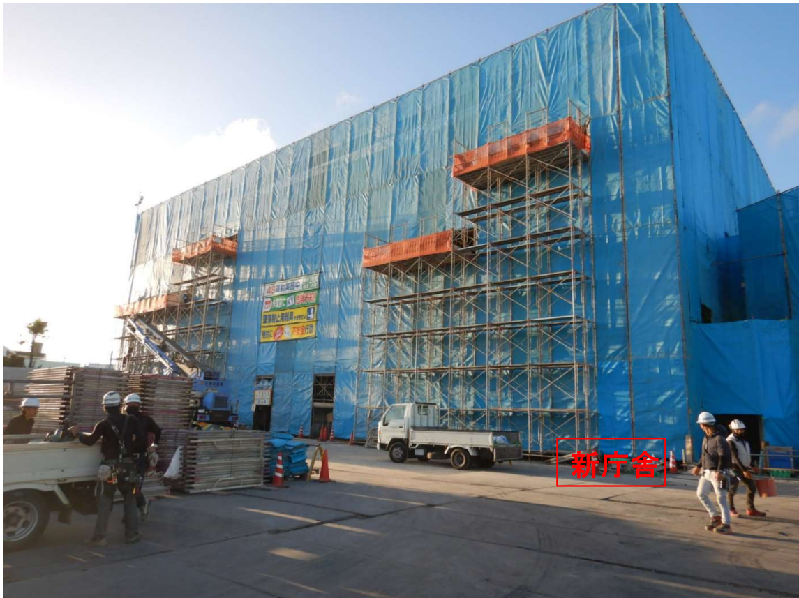
①新庁舎 赤瓦マスブロック工事施工中。西面塗装準備。
