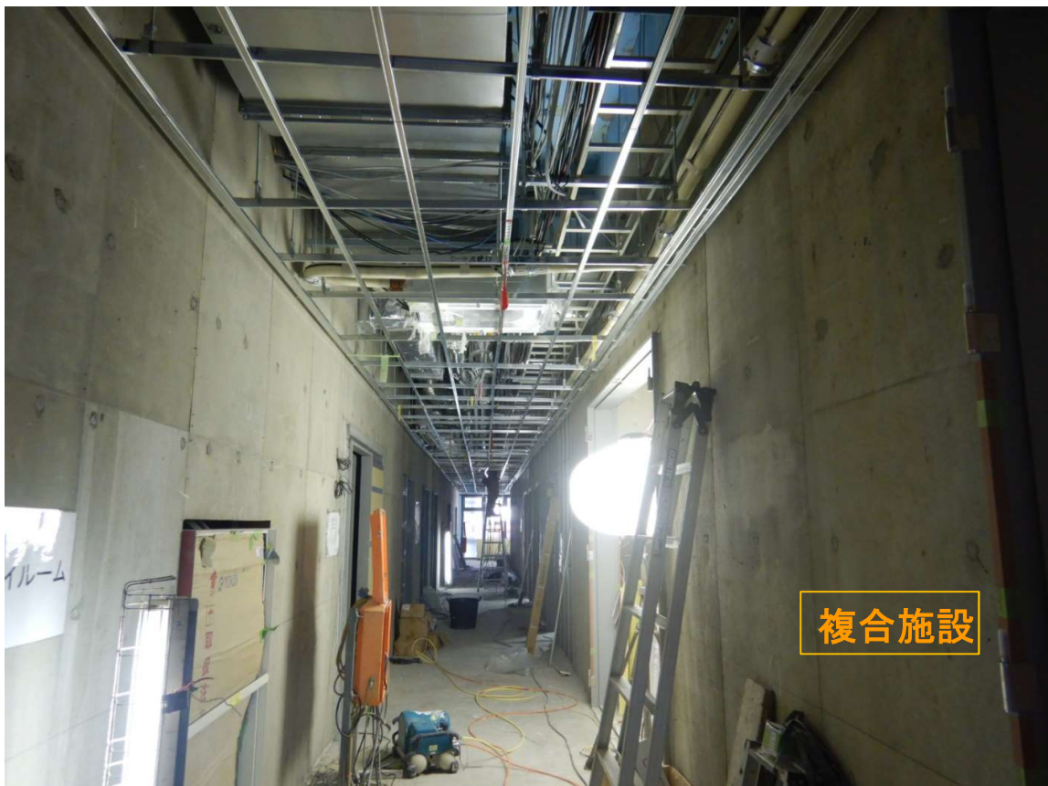
②複合施設 2階-軽鉄天井下地組み完了。
