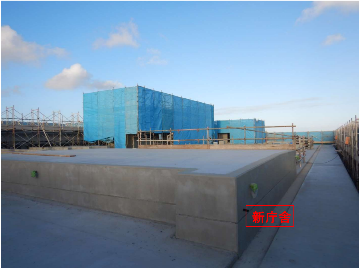
①新庁舎 屋上階-左官補修。
