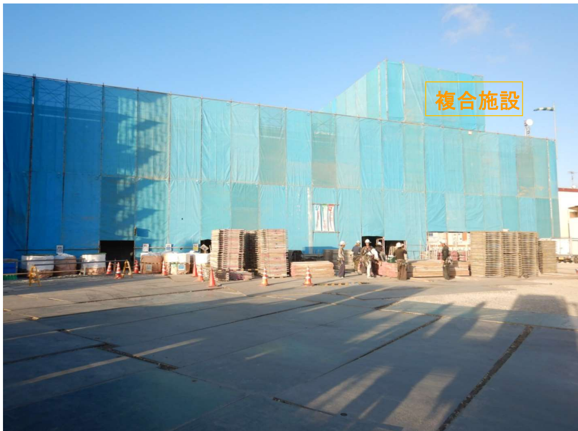
②複合施設 赤瓦マスブロック工事施工中。塗装前養生中。
