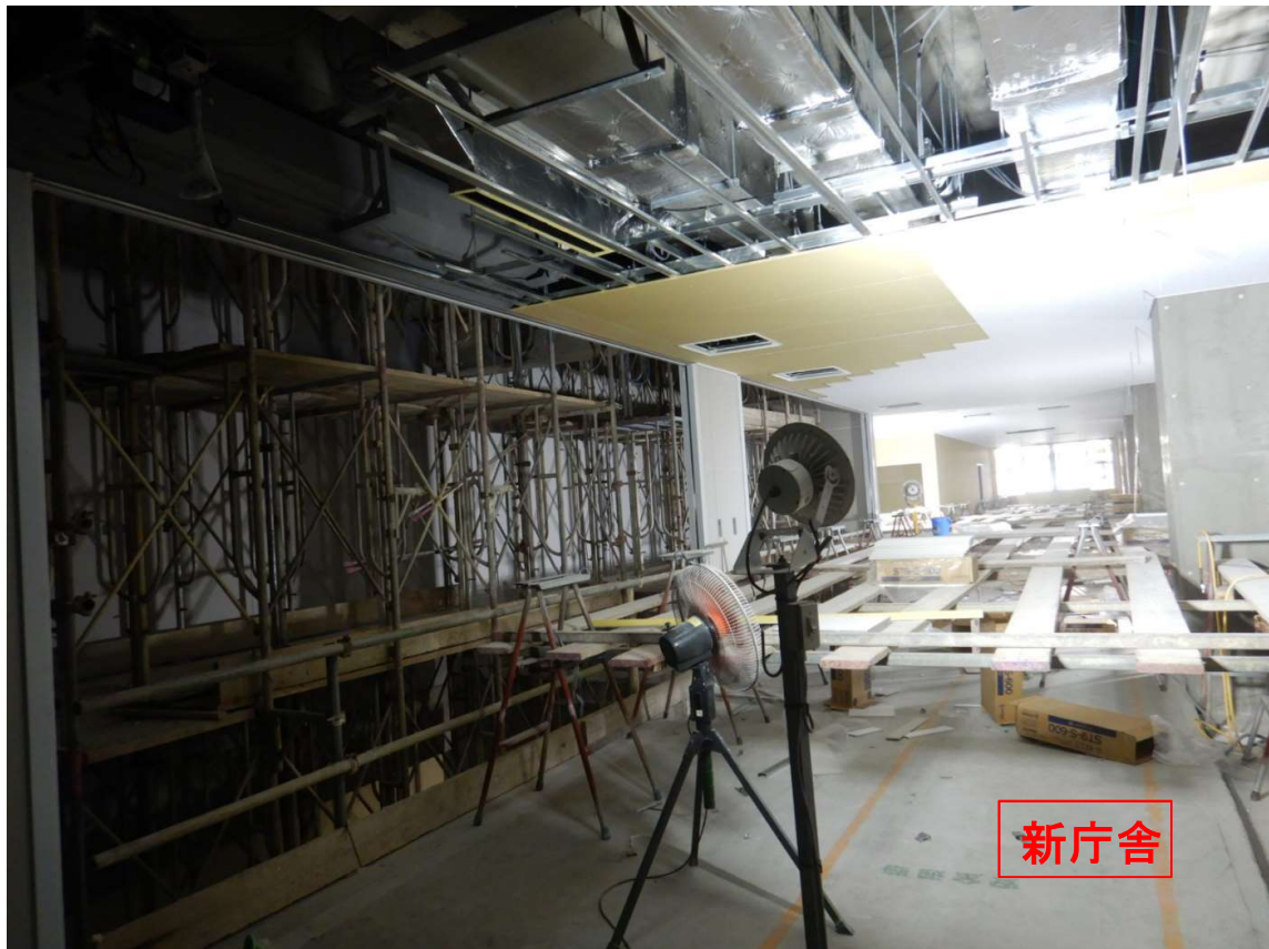
①新庁舎 2階-軽鉄天井下地ボード貼り
