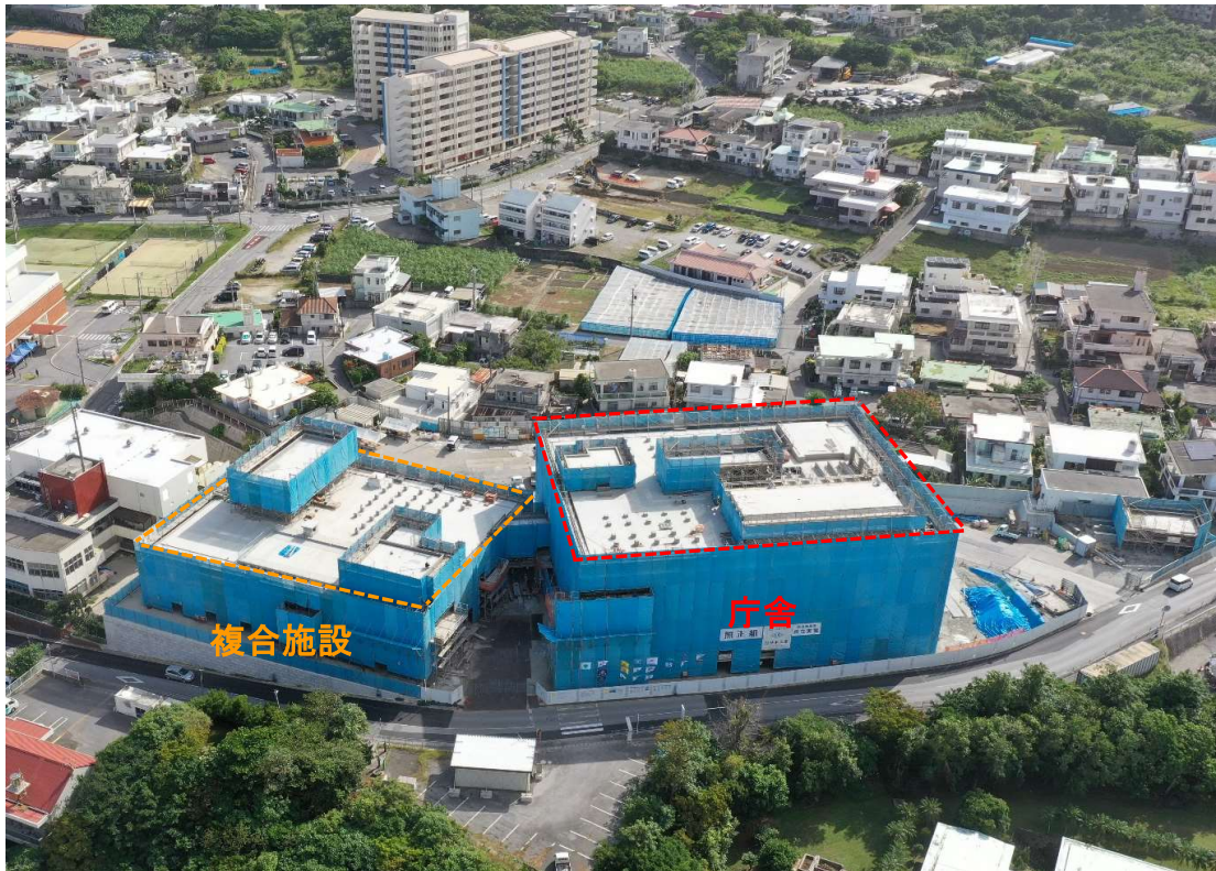
①全景写真【北側より】
