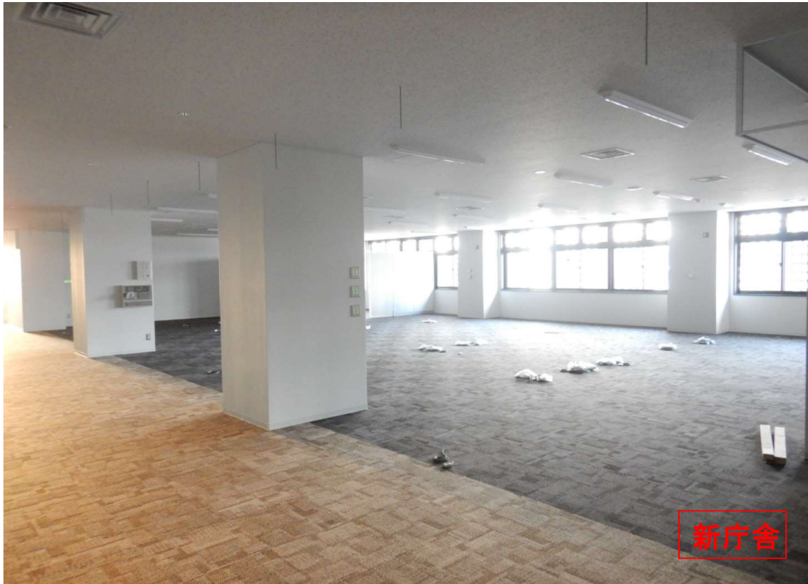
①新庁舎 3階-仕上完了。
