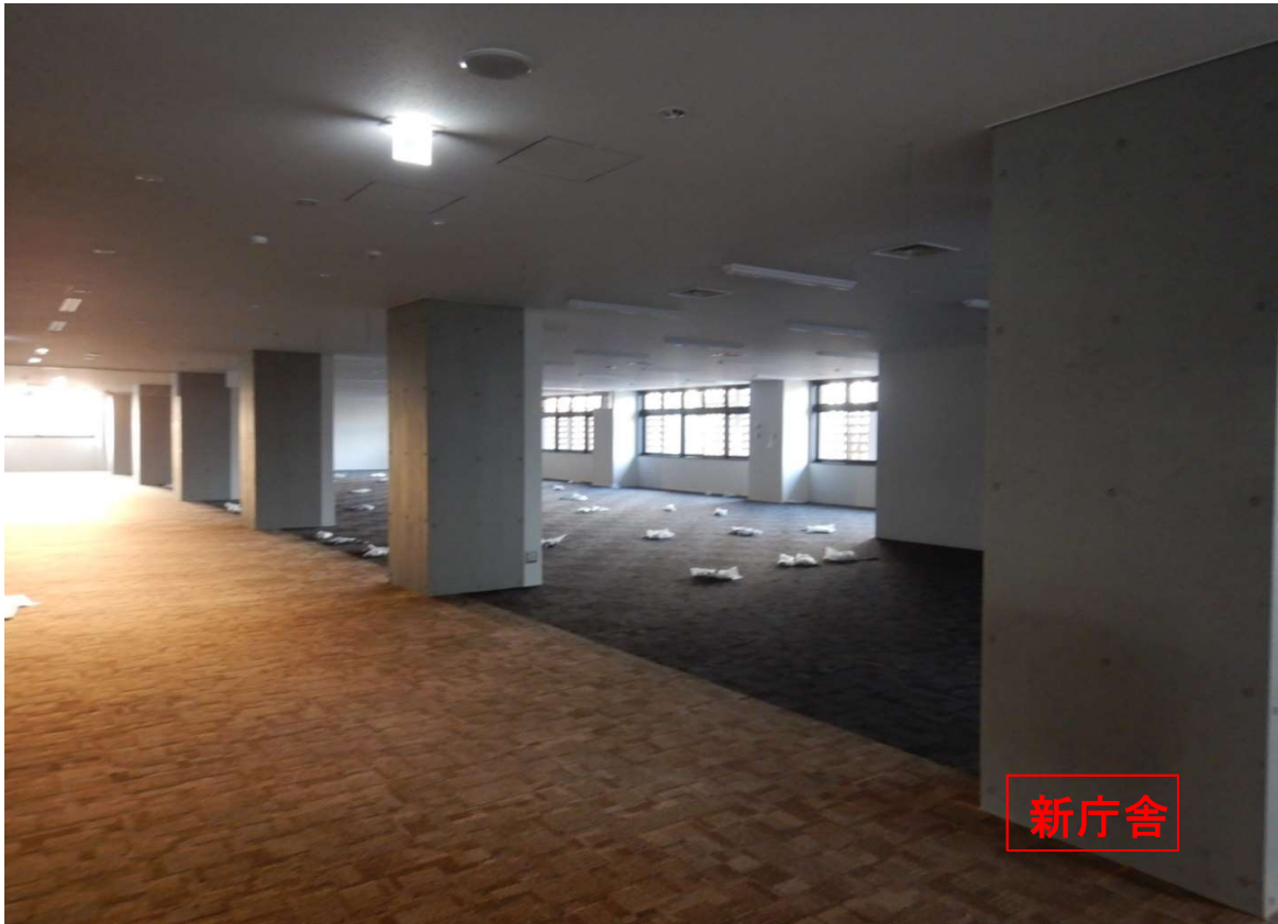
①新庁舎 2階-タイルカーペット張り完了。
