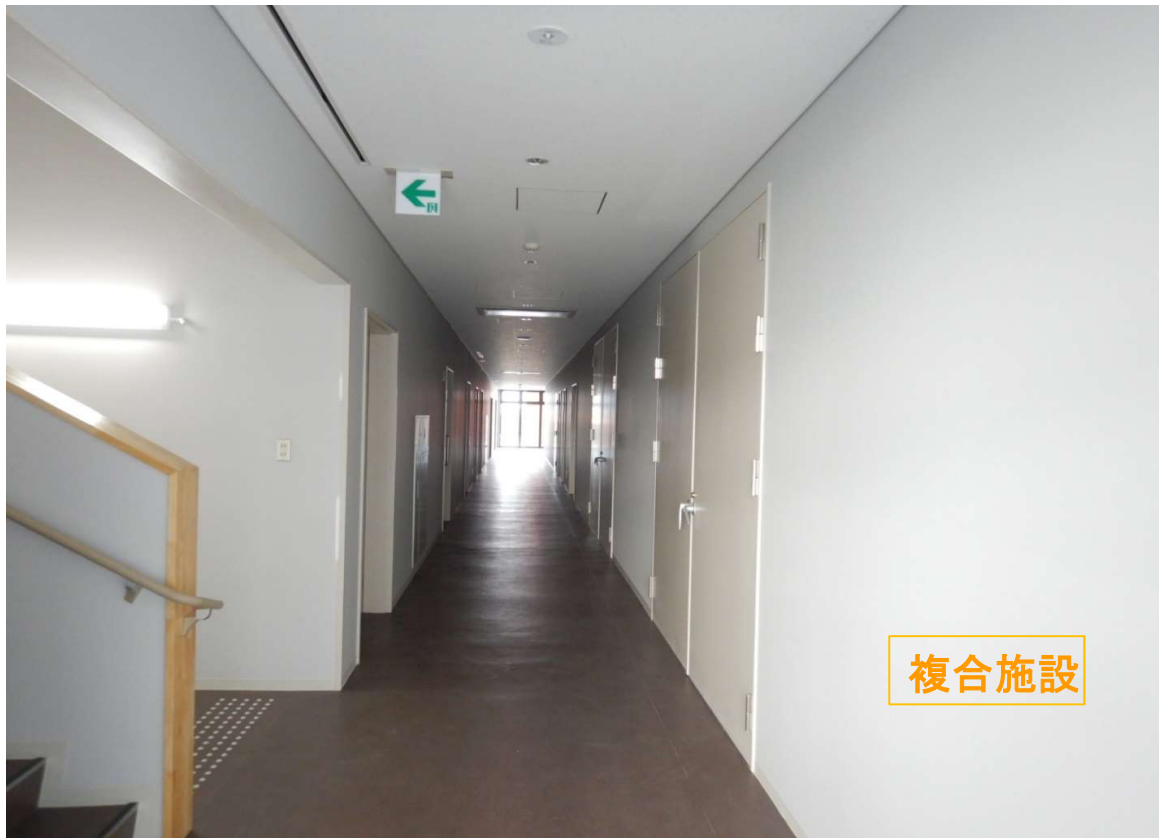
②複合施設 2階-壁仕上完了。
