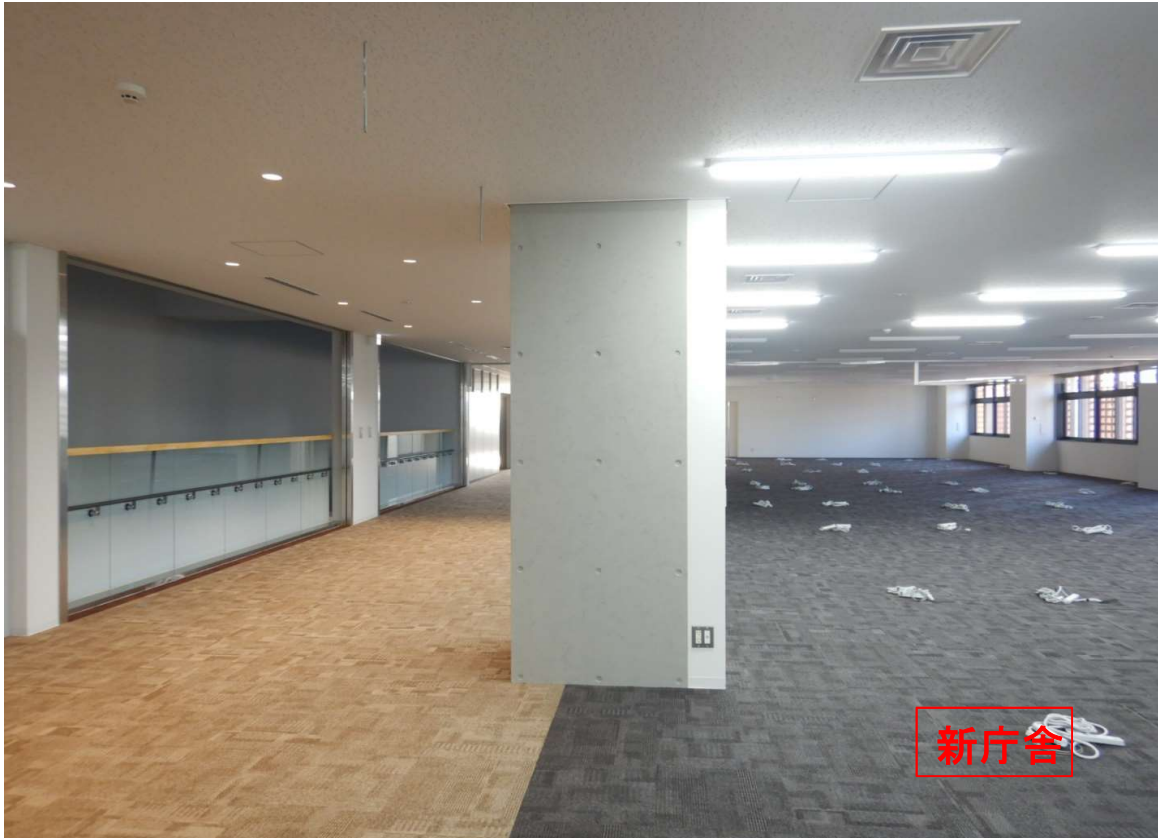
①新庁舎 2階-手すり設置完了。
