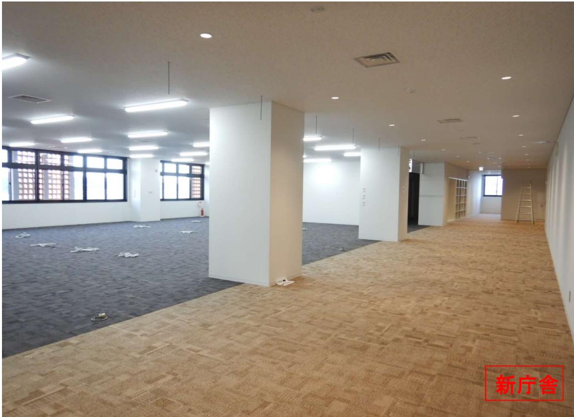
①新庁舎 3階-仕上完了。
