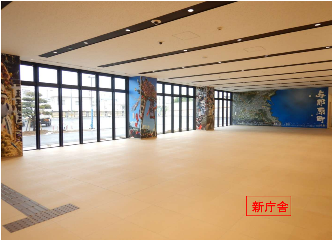
①新庁舎 1階-町民ラウンジ-壁面サイン工事中。
