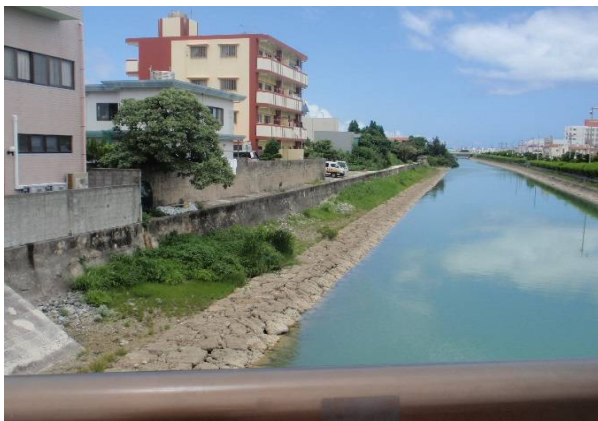
【整備予定箇所：国道与那原バイパスより撮影】
