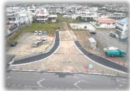
上 与 那 原 前 の 井 線 ( メ ー ヌ カ ー ) 工 事 中 の
