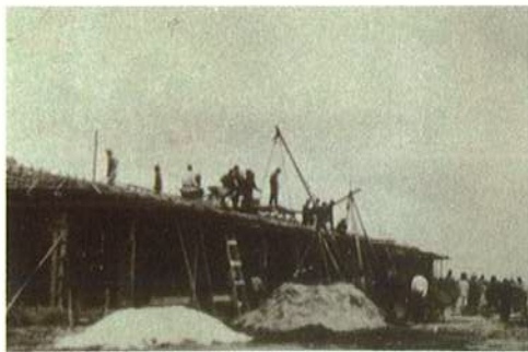
新敷地で校舎づくりの作業 (与那原中学校提供)
