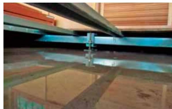
漏水により浸水した床下のようす
