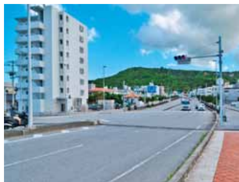
工事の進展がみられない(県道77号線)
