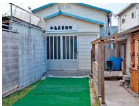
老朽化が進んでいる区事務所
