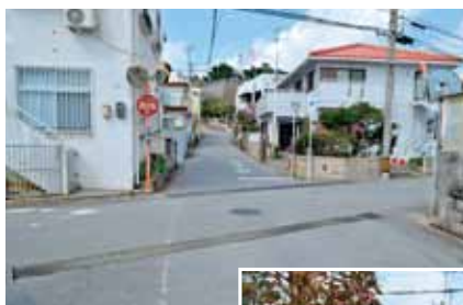
車両が多く、整備が必要な(浜田十字路)
