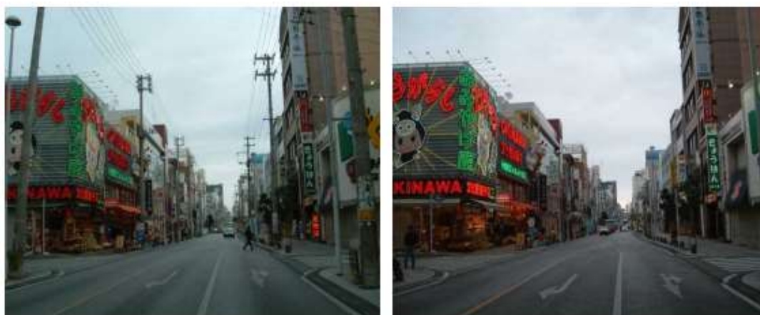
写真一2 国際通り(那覇市)の整備前後の状況(左:整備前、右:整備後) [出典:沖縄県無電柱化推進計画(令和4年3月沖縄県土木建築部)]
