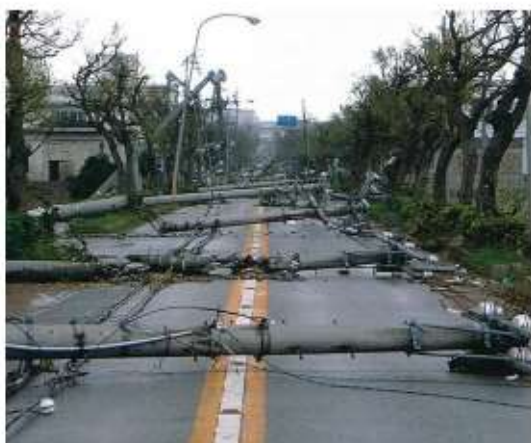
写真－1 台風による電柱倒壊状況
