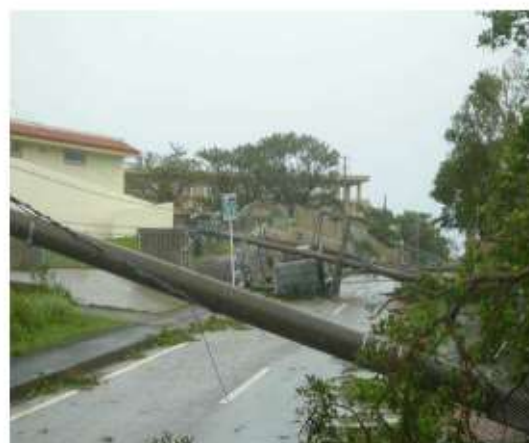
写真－1 台風による電柱倒壊状況
