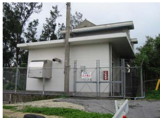
板良敷ポンプ室（板良敷区）
