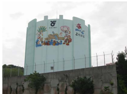
与那原第二配水池（江口区）
