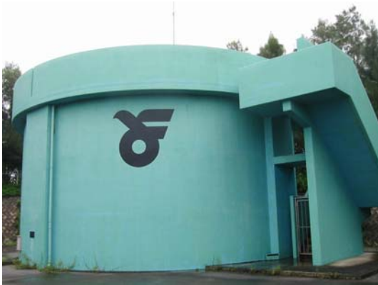
大見武配水池（大見武区）
