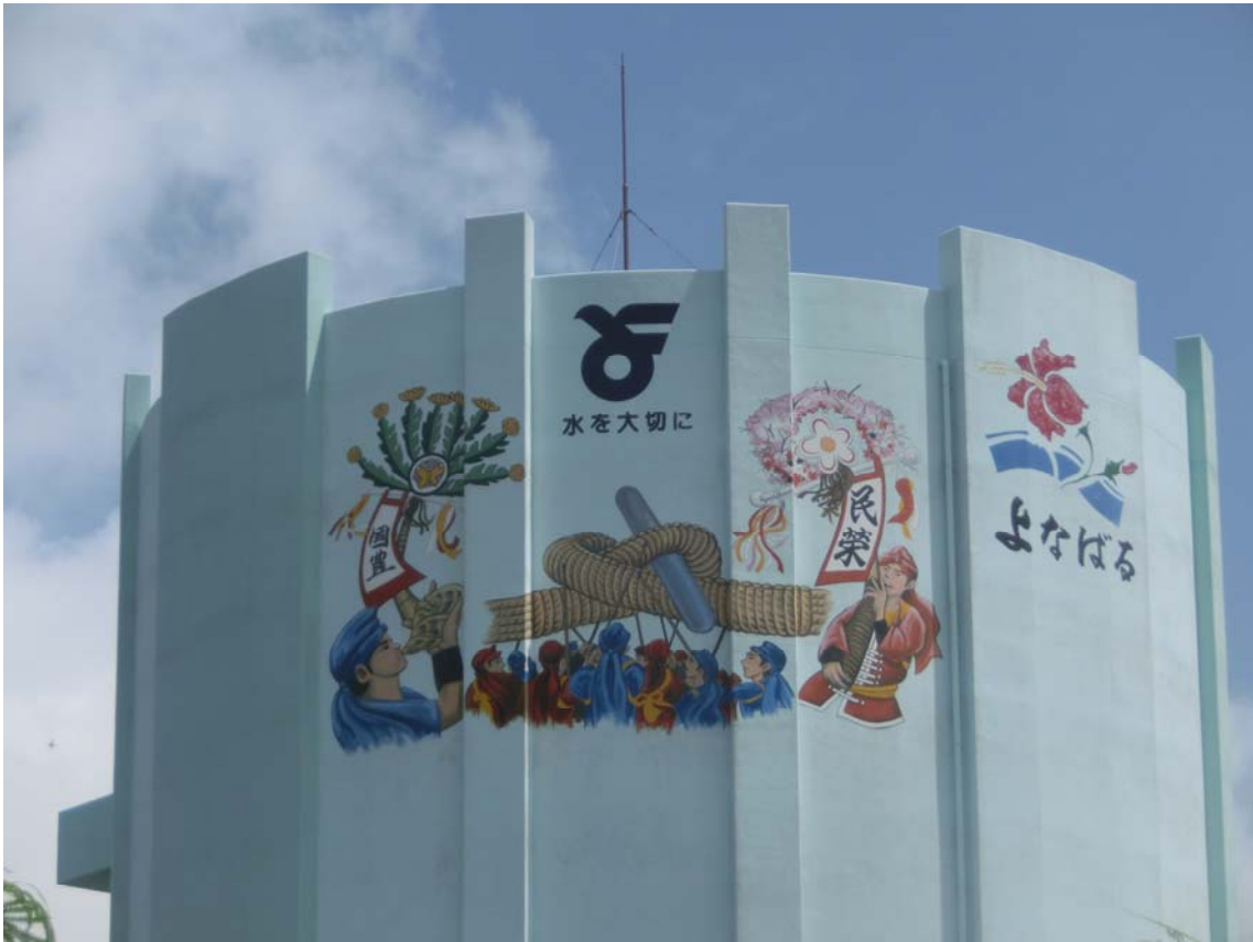
与那原第二配水池
