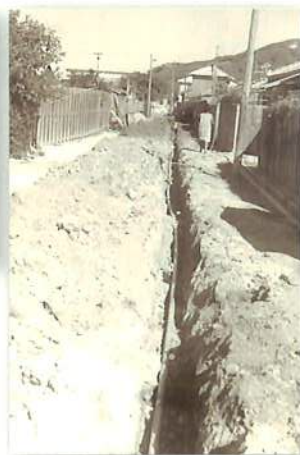
（右）中島・港区での工事の様子 （左）設置された水道管 一部は米軍指定の塩化ビニル製を使用しなければならなかった。
