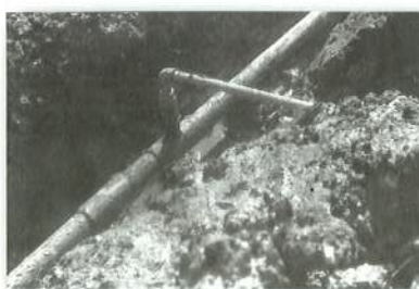
（右）中島・港区での工事の様子 （左）設置された水道管 一部は米軍指定の塩化ビニル製を使用しなければならなかった。
